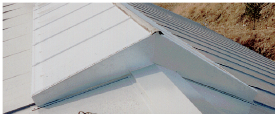
Färdigmonterad nock med tillklippta täckplåtar
